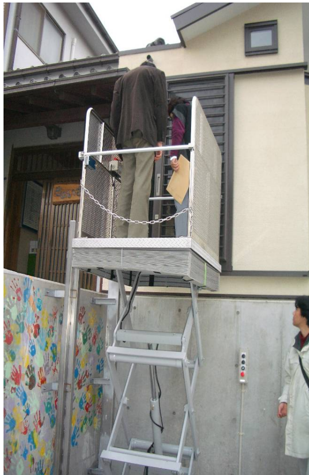
昇降式リフトの設置
